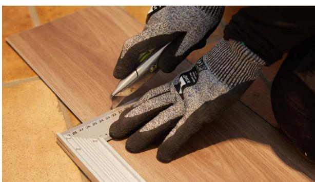
В местах, где сложно соединить планки Moduleo® Next при помощи подбивочного блока (например, у стены), можно использовать специальную скобу и молоток для соединения планок.
